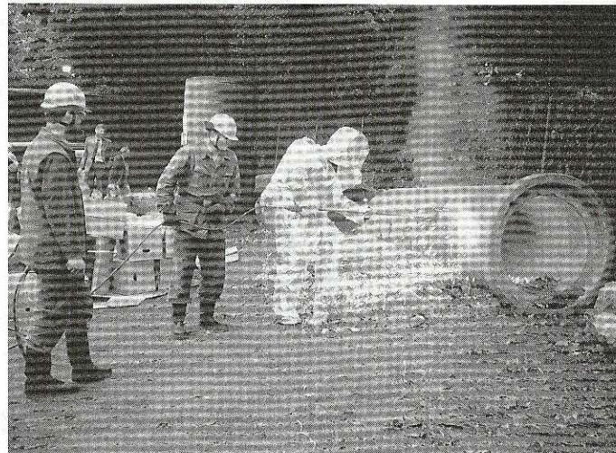
Immer wieder faszinierend: Der Einsatz der Sauerstofflanze. (Foto: Krüger)
